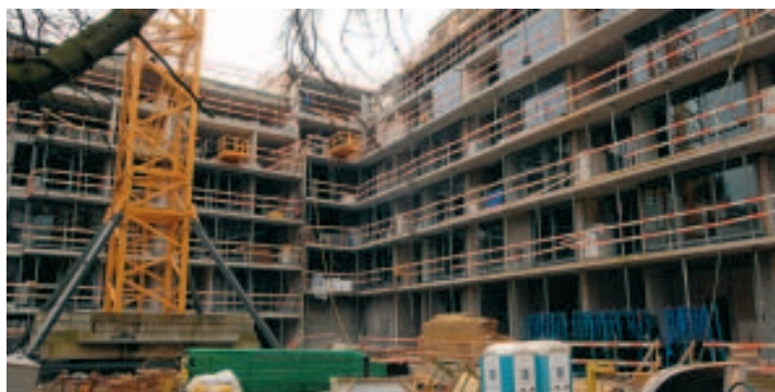
Le site encore en plein chantier. ■ V.FROMONT
